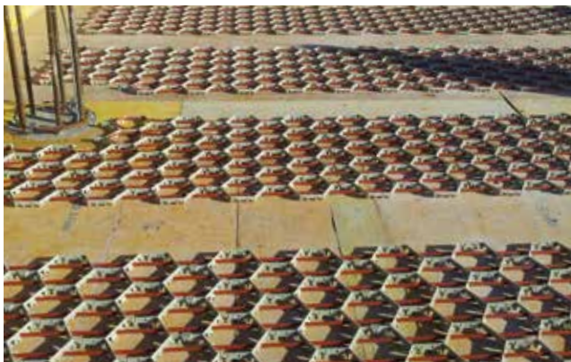
Födémzsaluzatra fektetett Wavin CW-90 regiszter panelek
