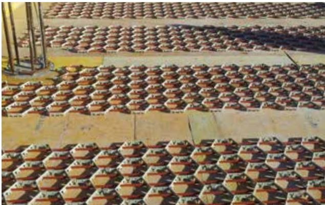
Födémzsaluzatra fektetett Wavin CW-90 regiszter panelek
