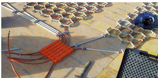
Betonkirekesztők a bekötővezetésekkkel védőcsőben vezetett fűtőcsővel
