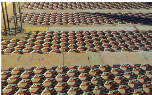
Födémzsaluzatra fektetett Wavin CW-90 regiszter panelek
