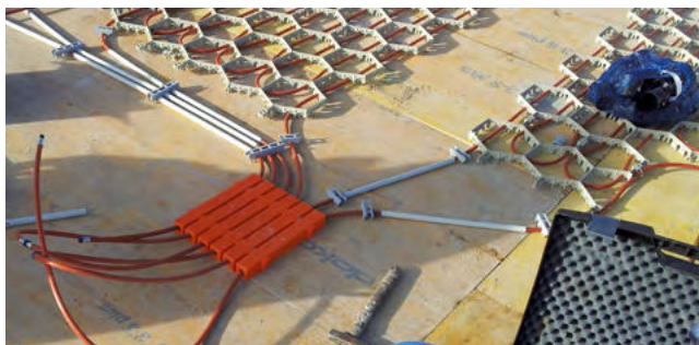
Betonkirekesztők a bekötővezetésekkkel védőcsőben vezetett fűtőcsővel
