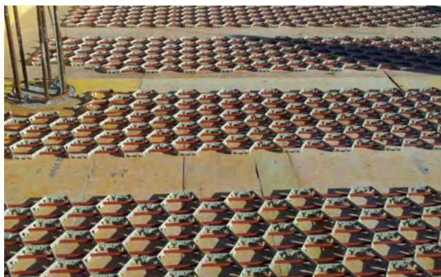
Födémzsaluzatra fektetett Wavin CW-90 regiszter panelek
